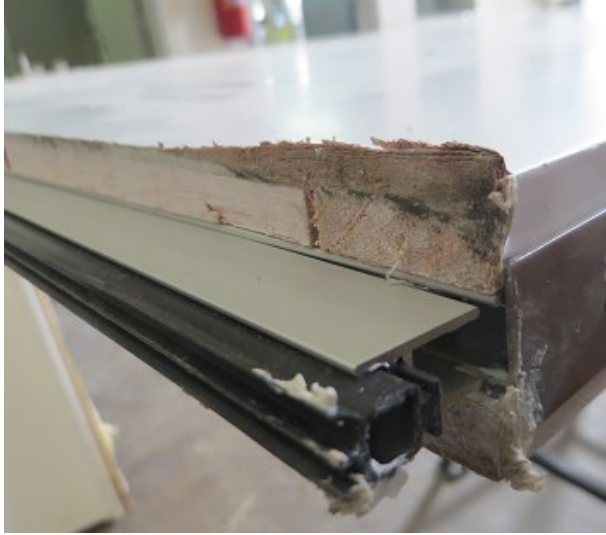
Foto 1 – Sistema de vedação com acionamento automático (acionado).
