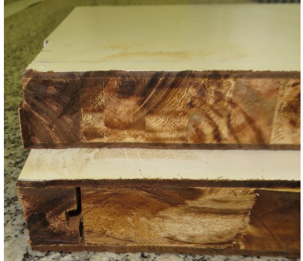
Foto 2 – Seção transversal de um dos montantes e da travessa superior do quadro da folha.
