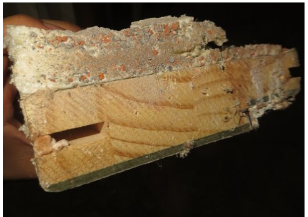
Foto 5 – Seção transversal do marco.
