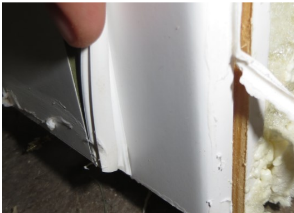
Foto 4 – Amortecedor de composto elastomérico presente no rebaixo do marco.
